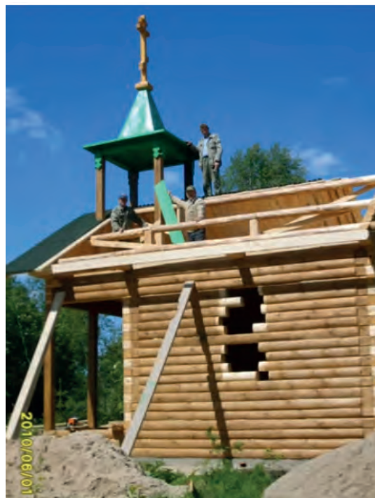
Строительство часовни преподобного Кирилла Челмогорского. 2010 г.
