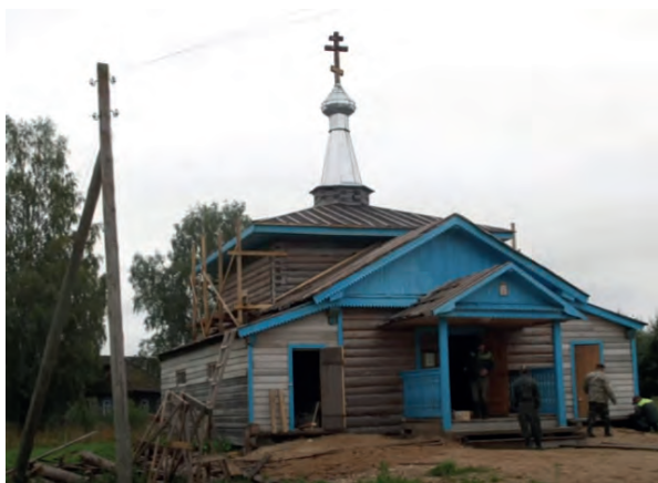
Село Лёкшма. Церковь пророка Божия Или. Завершающая стадия строительства храма. Строительство полностью велось самой общиной
