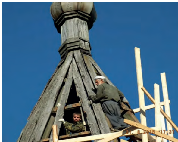
Деревня Река (Наволочный погост). Церковь великомученика Георгия Победоносца. Конец XIX в. Ремонт шатра колокольни. На лесах председатель приходской общины Ю. А. Тишинин
