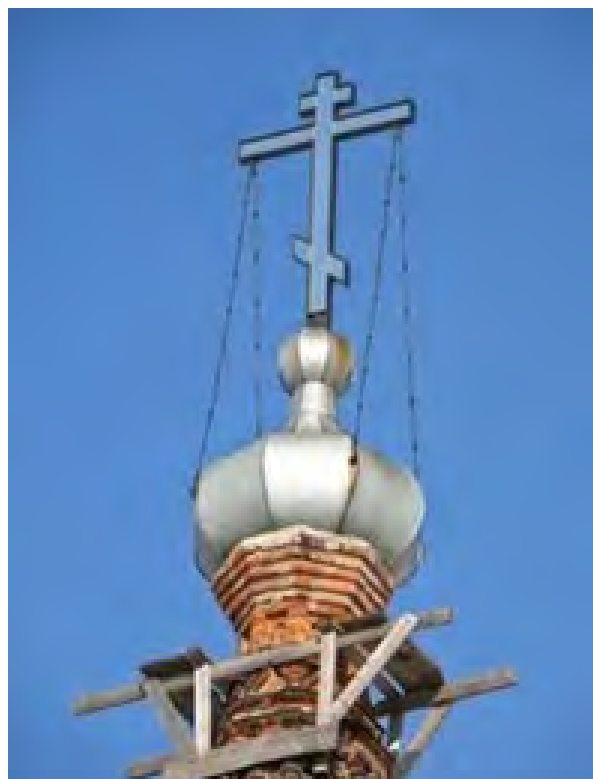
Восстановленный зеркальный крест на колокольне Спасообыденной церкви Сольвычегодска Котласского р-на Архангельской обл. Фото А. Колосова. 2010 г.
